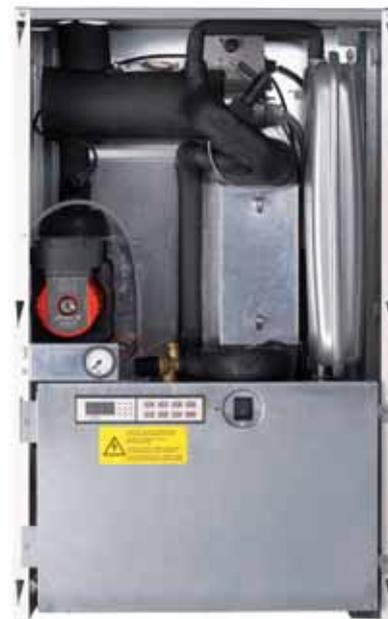
El diseño compacto hace posible la instalación del módulo hidráulico dentro de un mueble de cocina estándar.
